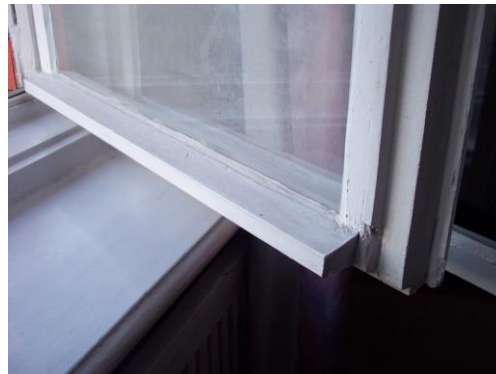
Abbildung 3: Kastenfenster in gutem Erhaltungszustand (Bildquelle Eike Gehrts, Linden)
