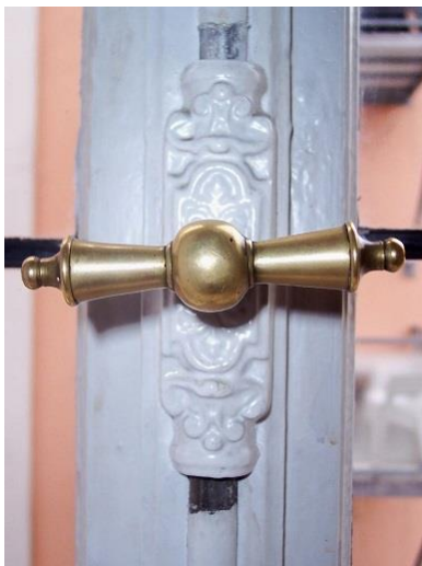
Abbildung 12: Griffolive an einem Baskülverschluss (Bildquelle Eike Gehrts, Linden)
