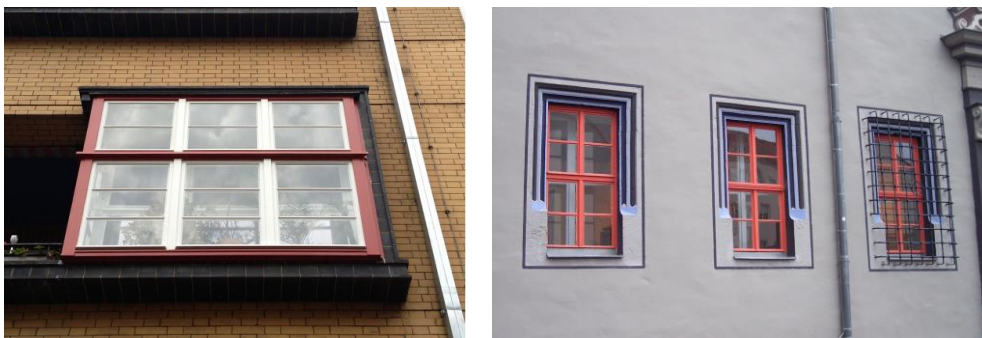
Abbildung 10: Runderneuerte Kastenfenster mit zweifarbiger Beschichtung (Bildquellen: Hans Timm Fensterbau, Berlin, links, Eike Gehrts, Linden, rechts)
